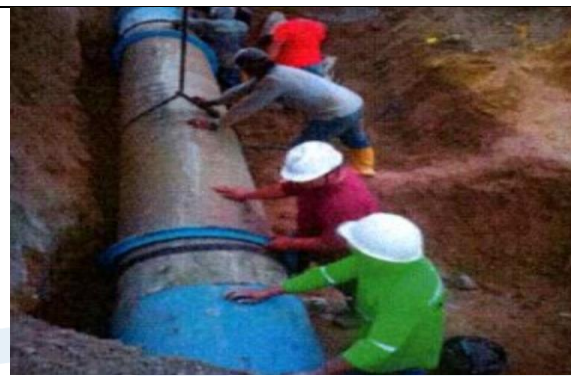
Reparación tubería Parroquia Eloy Alfaro
